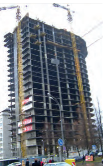
Рис. 1. Несущие конструкции стен, колонн и постнатяженных перекрытий пролетом 8 м здания «Gazoil Plaza» (Москва) из конструктивного легкого бетона фактических классов Вф45–Вф50
