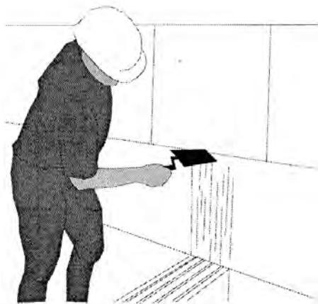
Рисунок 40 – Нанесение раствора для тонкошовной кладки на возведенную стену - нанести раствор для тонкошовной кладки на примыкающий к возведенной стене элемент кладки (см. рисунок 41);
