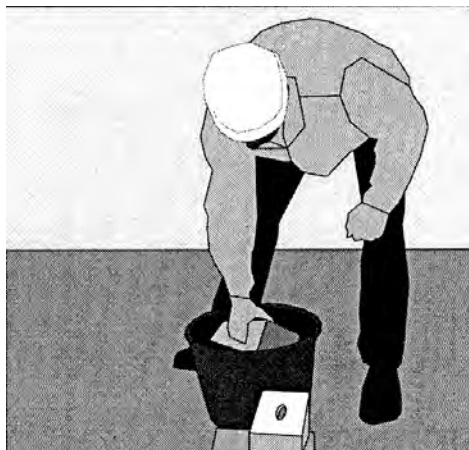
Рисунок 33 – Увлажнение блоков в жаркую погоду
