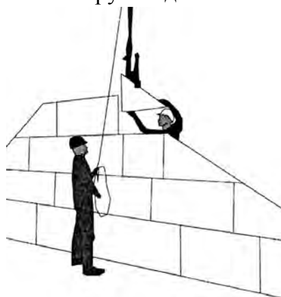
Рисунок 43 – Укладка полноразмерного блока с помощью крана малой грузоподъемности
